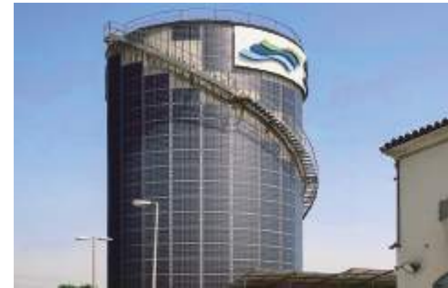
Fasada solarna ZEA | 30kW
