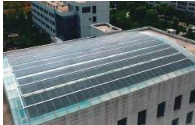
Zakrzywiony dach szklany Prowincja Shanxi, Chiny | 100kW
