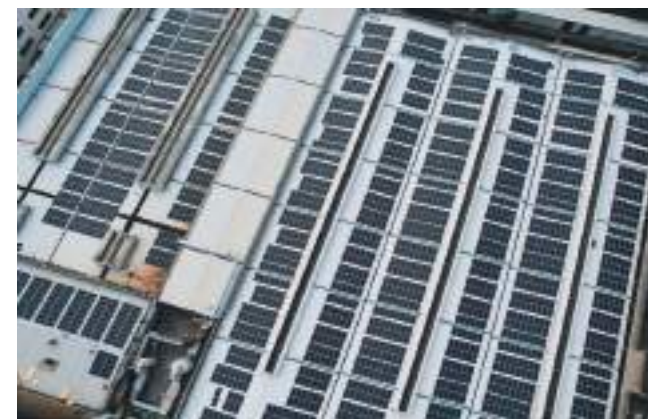
Dach o niskiej nośności Prowincja Jiangsu, Chiny | 1.2MW
