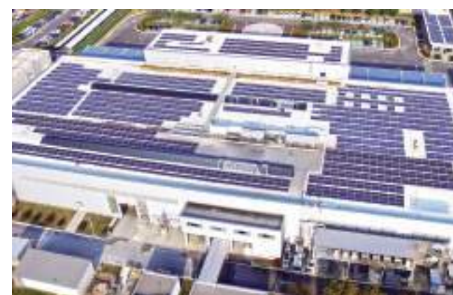
Dach o niskiej nośności Prowincja Jiangsu, Chiny | 530kW
